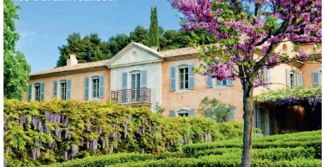
Après l'intervention du cabinet, une fois les travaux réalisés.
